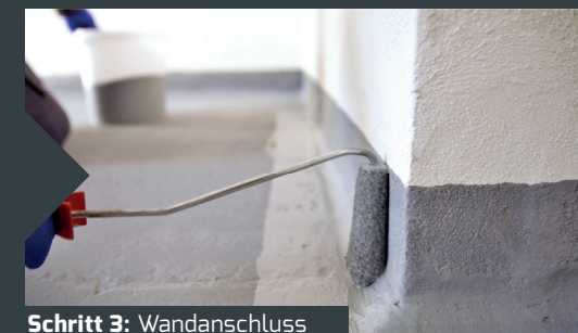
Schritt 3: Wandanschluss
